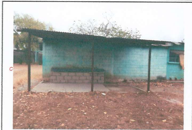
Foto1: Reparación de Cocina
