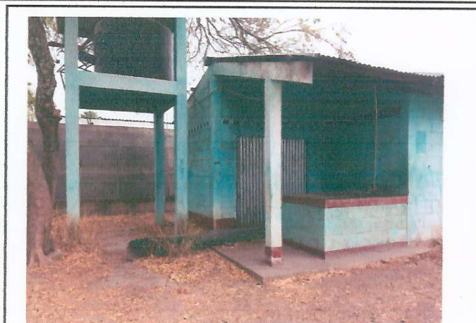
Foto 2: Instalación de Sanitarios
